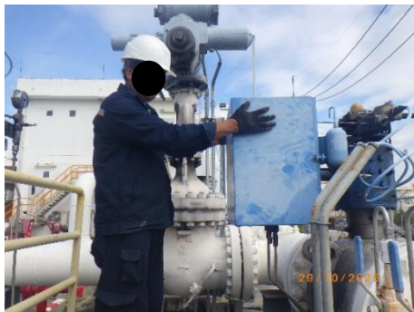
รูปที่ 2-14 การตรวจสอบระบบ ESD Valve
