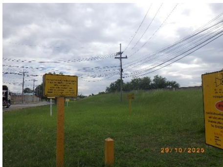
รูปที่ 2-15 ป้ายแสดงตำแหน่ง Block Valve
