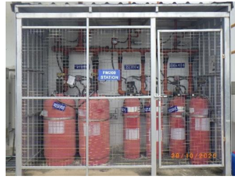
รูปที่ 2-19 อุปกรณ์ป้องกันอัคคีภัยรอบพื้นที่โครงการ
